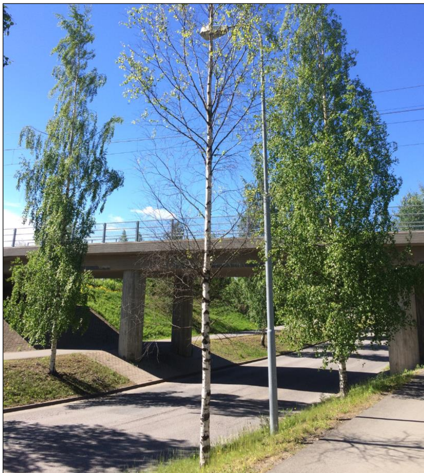
Kuva 5 Perkkiöntie siltapaikka radan itäpuolelta kuvattuna.
