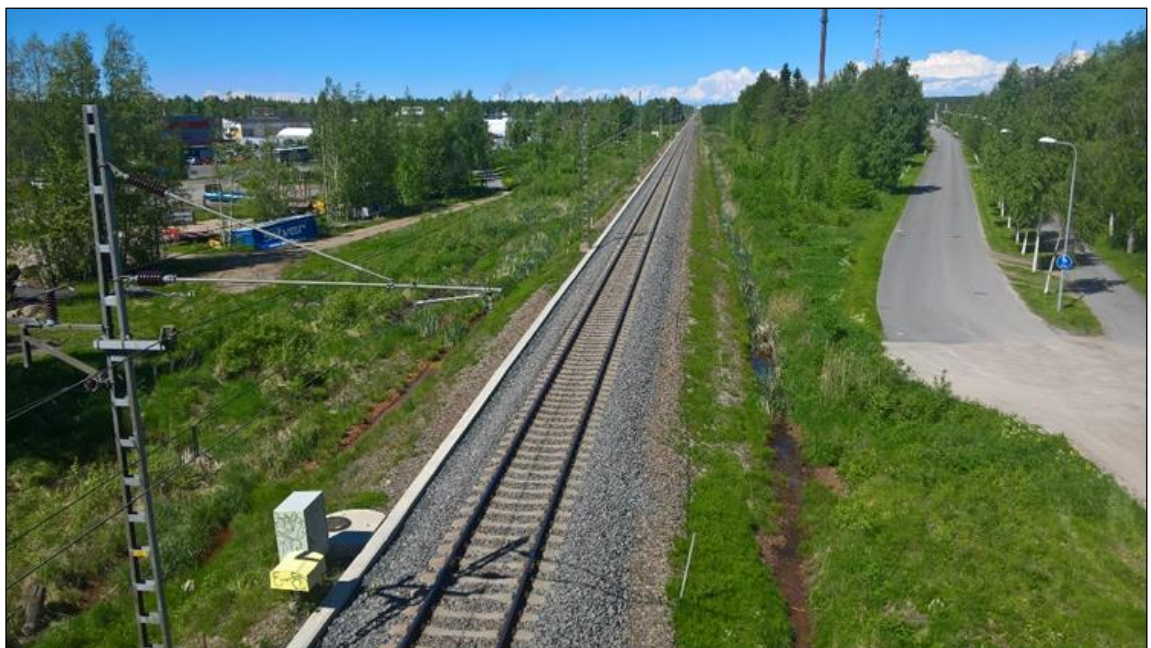
Kuva 4 Näkymä Oulunlahden ylikulkusillalta pohjoisen suuntaan.
