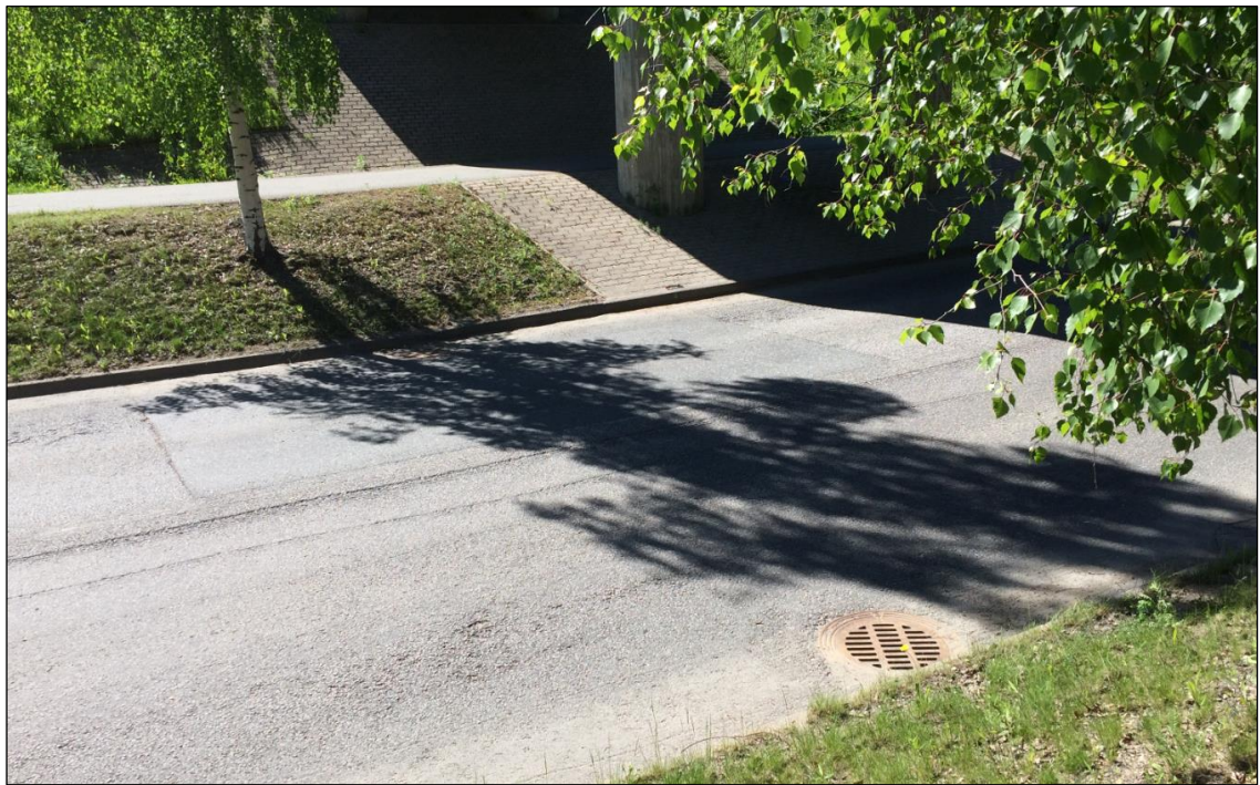
Kuva 14 Perkkiöntien alimman kohdan sadevesijärjestelmiä täytyy hieman siirtää nykyisestä sijainnista uuden alikulkusillan tukilinjan sijainnin takia.
